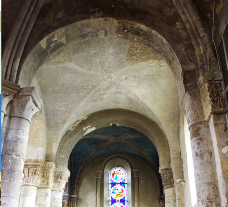
Voûte d'arêtes dans l'église Saint-Hildevert de Gournay-en Bray.
